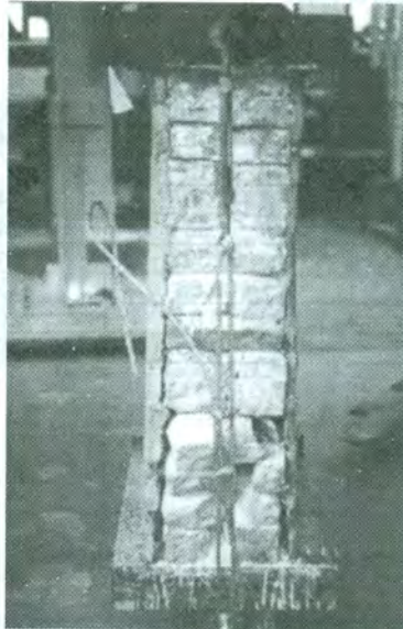
Σχήμα 10. Ολίσθηση, θραύση και αποκόλληση των λίθων Figure 10. Slipping, failure and spalling out of stones
