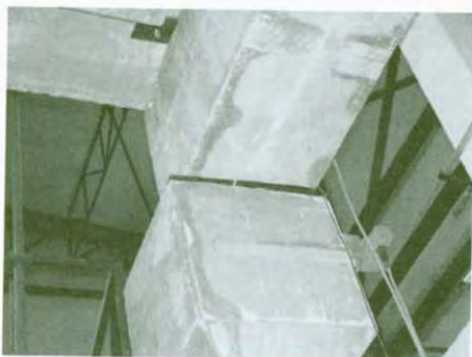
Φωτογραφία 2. Δοκίμιο I: Λεπτομέρεια έδρασης δοκού-υποστυλώματος
