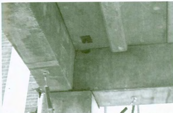
Φωτογραφία 4. Δοκίμιο Π: Λεπτομέρεια έδρασης δοκού-υποστυλώματος μετά την πειραματική διαδικασία
