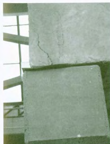
Φωτογραφία 6. Δοκίμιο Π: Λεπτομέρεια έδρασης δοκού-υποστυλώματος μετά την πειραματική διαδικασία
