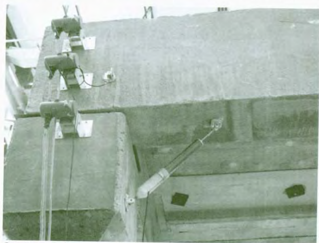
Φωτογραφία 3. Δοκίμιο II: Λεπτομέρεια έδρασης δοκού-υποστυλώματος – Θέσεις οργάνων μέτρησης
