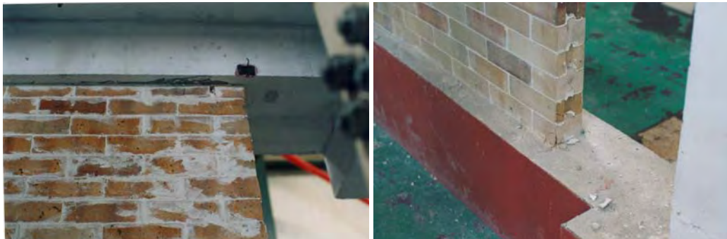
Σχήμα 11. Δοκίμιο Δ4-T1-BWA: Οριζόντια ρωγμή στη βάση και στην κεφαλή της τοιχοπλήρωσης.
