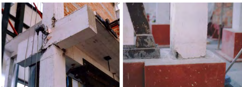
Σχήμα 14. Δοκίμιο Δ8- T5- ΛSFRA: Αστοχία στους κόμβους δοκών- υποστυλωμάτων, λυγισμός ε κατακόρυφο οπλισμό στον πόδα υποστυλώματος ισογείου.
