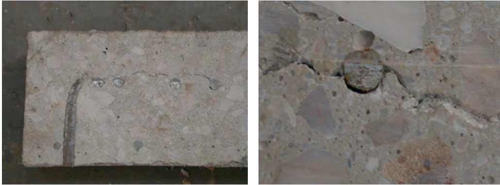
Σχήμα 17. Φάση II: Οριζόντια ρωγμή στη θέση αγκύρωσης του κεκαμένου οπλισμού της δοκού και κατά μήκος των διατομών του οπλισμού της πλάκας.
