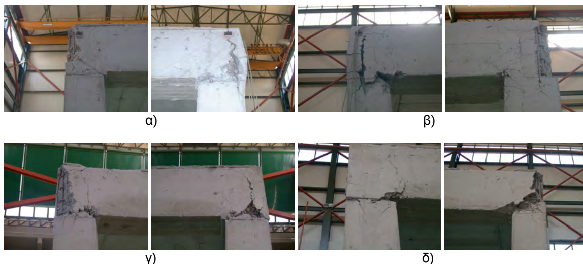
Σχήμα 13. Δοκίμιο VII-B: Ρωγμές στην α) Ανατολική και β) Βόρεια όψη, γ): Δυτική όψη και δ): Νότια όψη.
