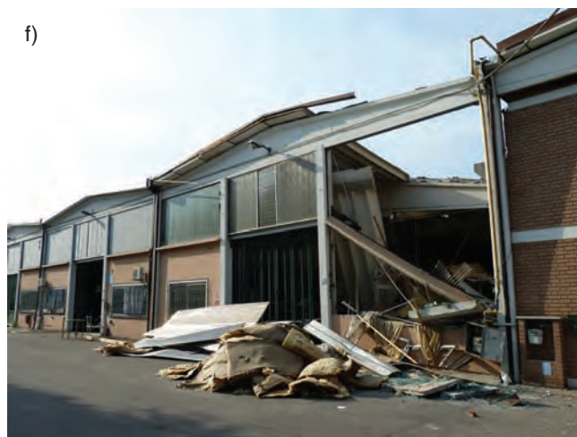
Fig. 32 a to f Simply supported prefabricated beams for the roofing systems and without any reliable anchoring were subjected to a combination of a very strong-impact-type-vertical component with a strong horizontal one. Those images of destruction are typical around the epicentral region. Travi di copertura prefabbricate in semplice appoggio, prive di collegamenti affidabili, soggette alla combinazione di una forte componente sismica verticale e di una forte componente sismica orizzontale. Immagini di danni di questo tipo sono caratteristiche delle zone epicentrali del terremoto.
