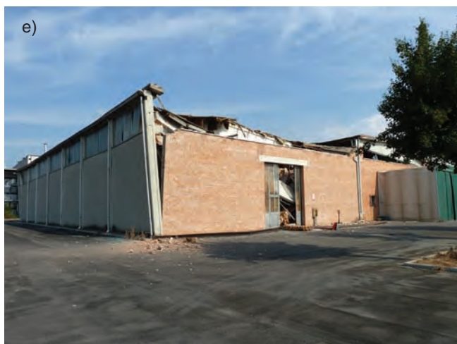
Fig. 32 a to f Simply supported prefabricated beams for the roofing systems and without any reliable anchoring were subjected to a combination of a very strong-impact-type-vertical component with a strong horizontal one. Those images of destruction are typical around the epicentral region. Travi di copertura prefabbricate in semplice appoggio, prive di collegamenti affidabili, soggette alla combinazione di una forte componente sismica verticale e di una forte componente sismica orizzontale. Immagini di danni di questo tipo sono caratteristiche delle zone epicentrali del terremoto.
