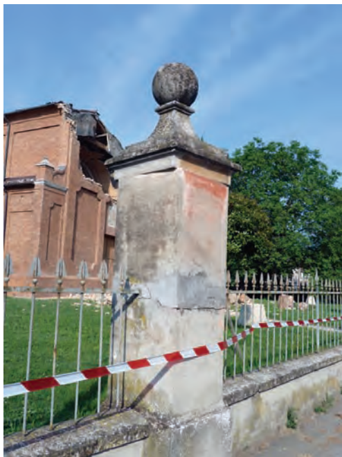
Fig. 22. The sculpture has not any horizontal translation; only torsion due to unsymmetrical friction at its base. Its dimensions are quite small to attribute this motion to any peculiarity of the horizontal ground motion. La scultura non mostra segni di traslazione orizzontale, ma esclusivamente torsione a causa di un attrito non simmetrico alla base. Le sue dimensioni sono troppo piccole per poter attribuire questo tipo di spostamento a qualche peculiarità del moto orizzontale del terreno.
